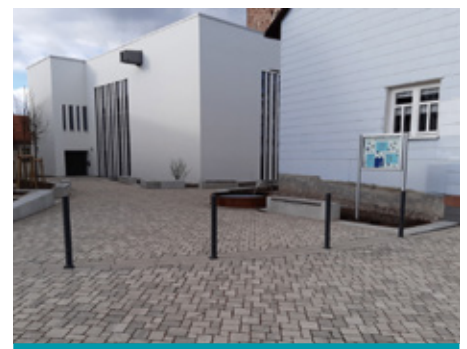
Der neue Kirchenvorplatz ist der erste Baustein des Heringer Stadtumbaus.
